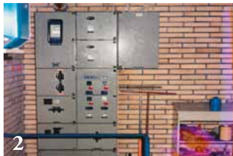
2. viser den første rigtige el-tavle som i samarbejde med tavlen på foto 4 udgjorde styringen.
