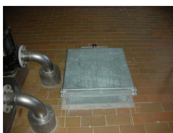
Nedgang rentvandstank
