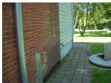
Tilbygning lager Målerbrønd th.
