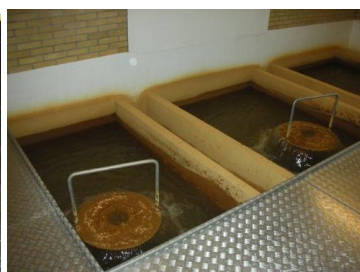
Åbne sandfiltre Variable udløbshøjder
